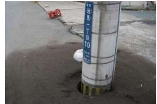
電柱の沈下
