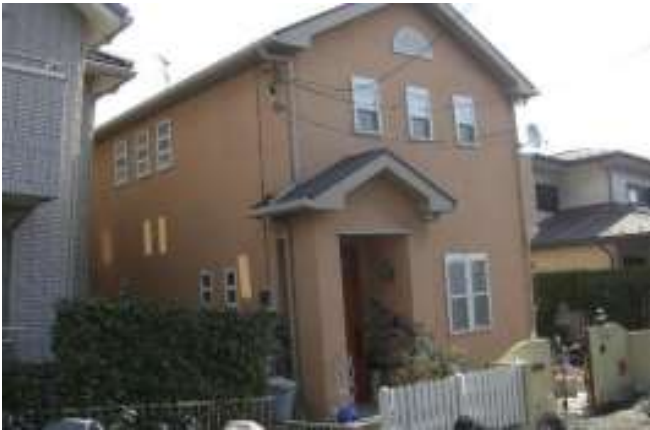
戸建て住宅の沈下・傾斜
